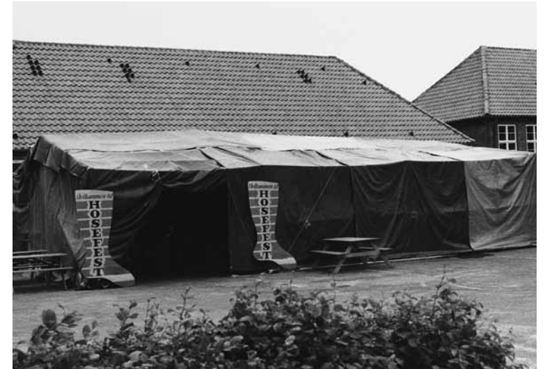
6. Det 1. Husetelt opstillet i skolegården 1963.
